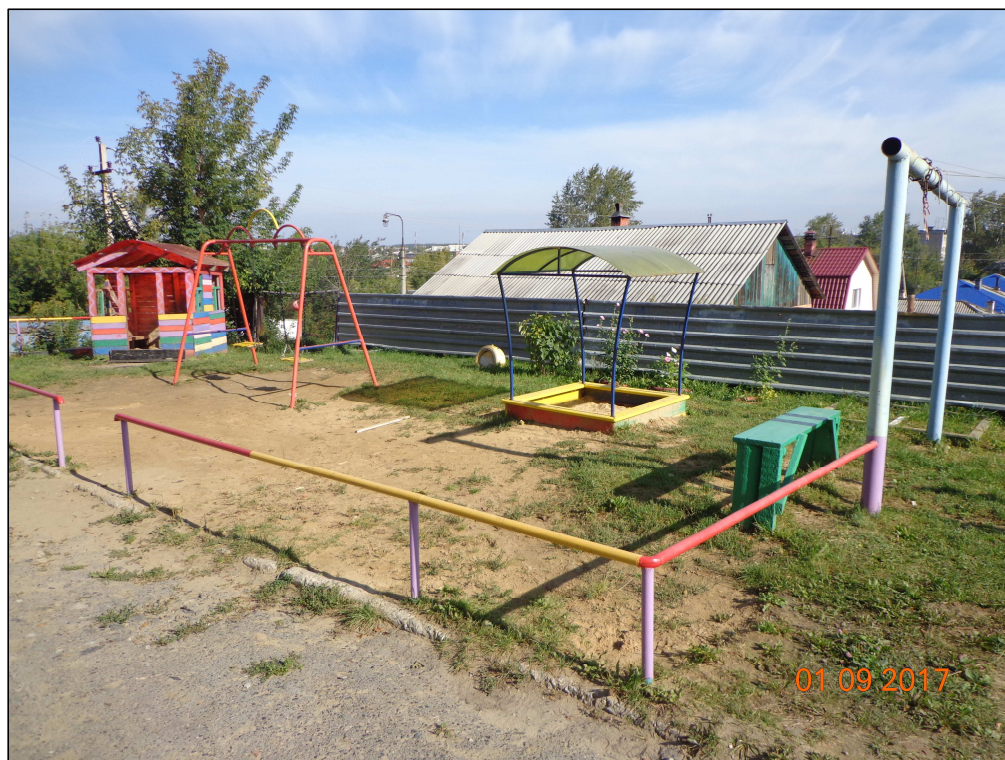
Рис.11. Существующее металлическое ограждение Н=0.5м. Качели 2-х местная, домик, песочница, скамья, бельевая, износ и разрушение бордюрного камня
