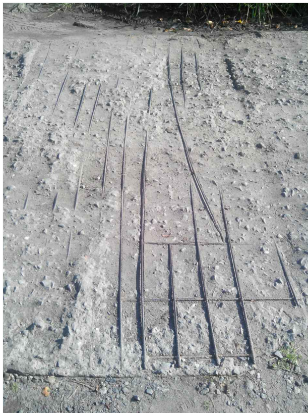
Рис.17. Износ и разрушение поверхности покрытия железобетонных плит
