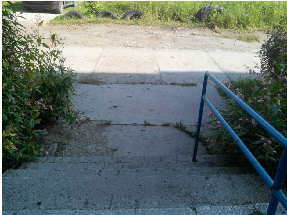
Рис.11. Ограждение из колес. Отсутствие скамьи и урны возле подъезда
