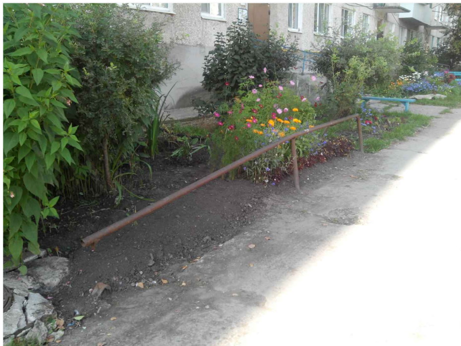
Рис.12. Ограждение металлическое Н=0.5м
